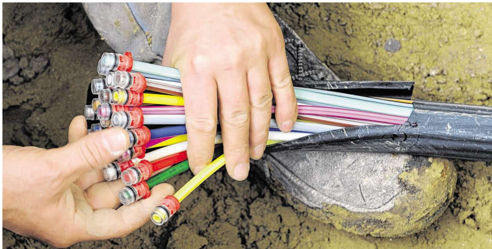
Die Deutsche Glasfaser Netz Entwicklung GmbH (DGF) will in Roetgen und Simmerath ein neues Glasfasernetz bis in die einzelnen Häuser verlegen. Das würde deutliche höhere Übertragungsraten ermöglichen als bisher. Foto: dpa
