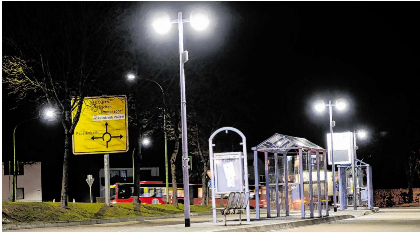
Kleiner und heller: Im Laufe eines Jahres wurde die Straßenbeleuchtung in der Gemeinde Simmerath auf LED umgerüstet.
