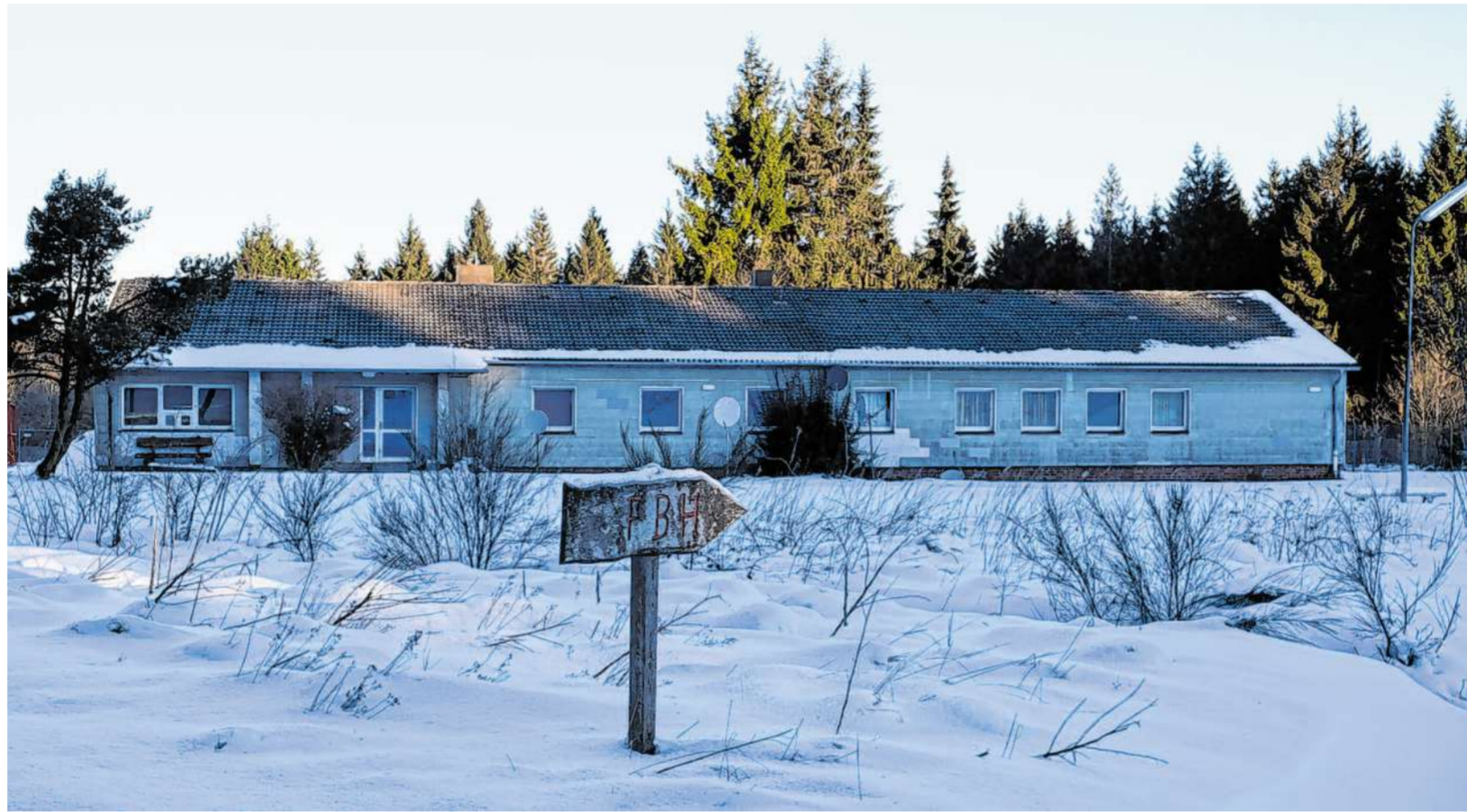
Immer wieder im Blickpunkt steht die Flüchtlingsunterkunft Langschoß: Auslöser der Diskussion sind die sanierungsbedürftigen Gebäude und die abgelegene und nicht gerade der Integration dienende Lage mitten im Wald. Foto: P. Stollenwerk
