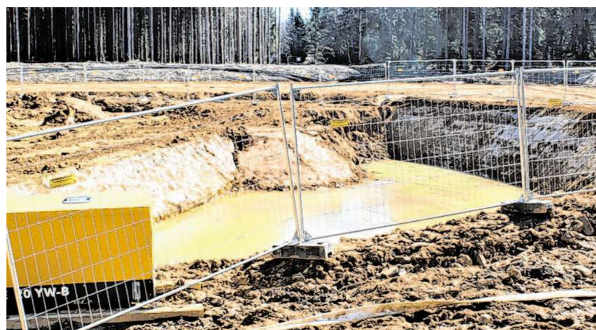
Tümpel statt Baugrube: Das Wasser darf laut Genehmigung abgepumpt werden, aber nicht in die Inde gelangen. Foto: Günther Sander
