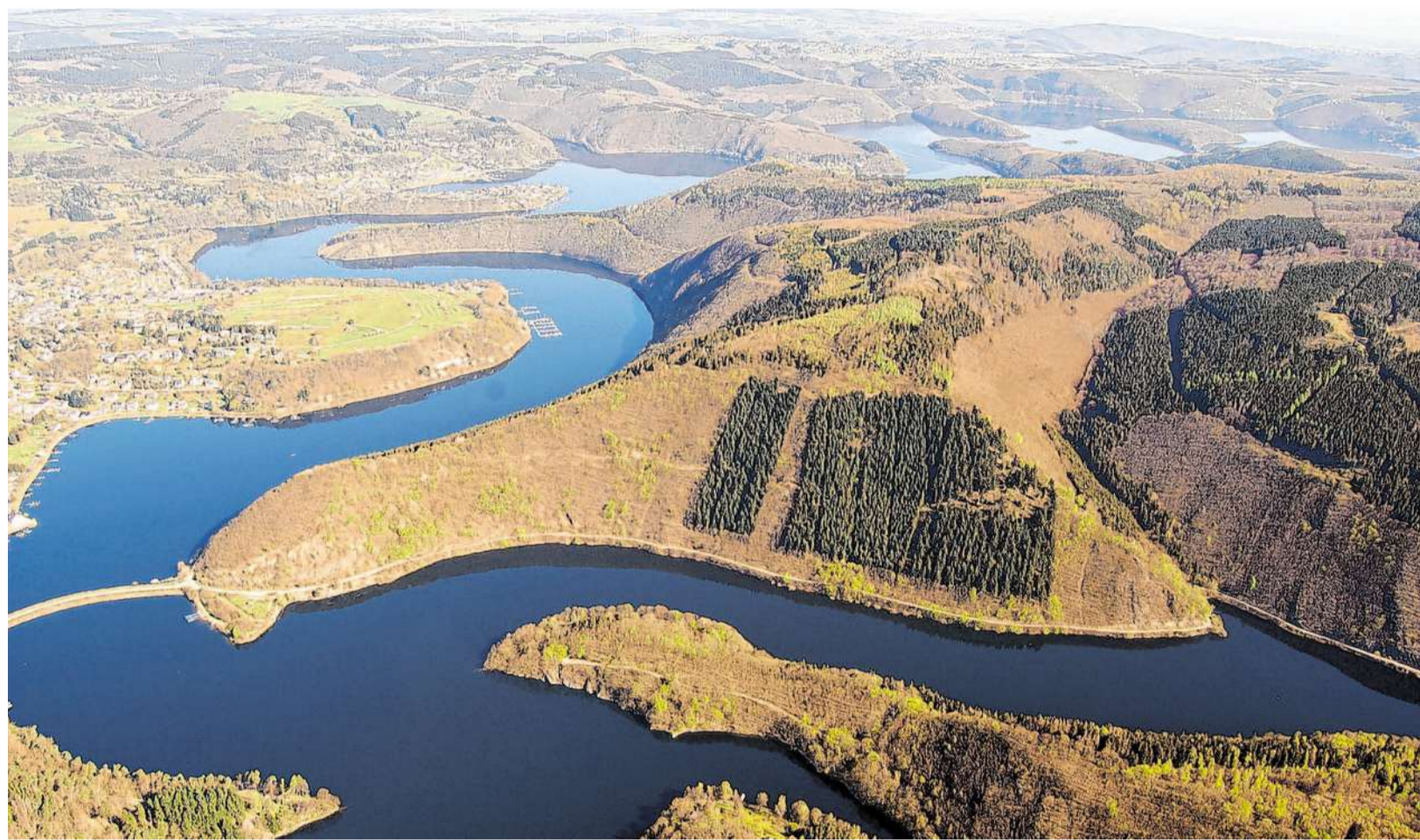
Der Wasserverband Eifel-Rur (WVER) betreibt sechs Talsperren in der Nordeifel (unter anderem die Rurtalsperren/Bild) sowie 44 Kläranlagen und über 800 Sonderbauwerke in funktionalem Zusammenhang mit der Abwasserreinigung. Außerdem betreut er 1900 Kilometer Gewässerstrecken und verfügt über eine Vielzahl an Hochwasserschutzanlagen wie Rückhaltebecken und Dämme.
