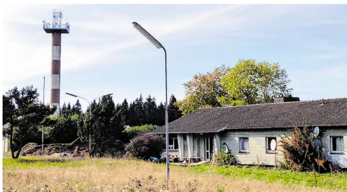
Ein dicker Batzen Sanierungskosten wurde durch die Gemeindeverwaltung für die Flüchtlingsunterkunft Langschoß ermittelt. Bis 2022 wurde hier ein Unterhaltungsrückstau von fast 452 000 Euro festgestellt.
