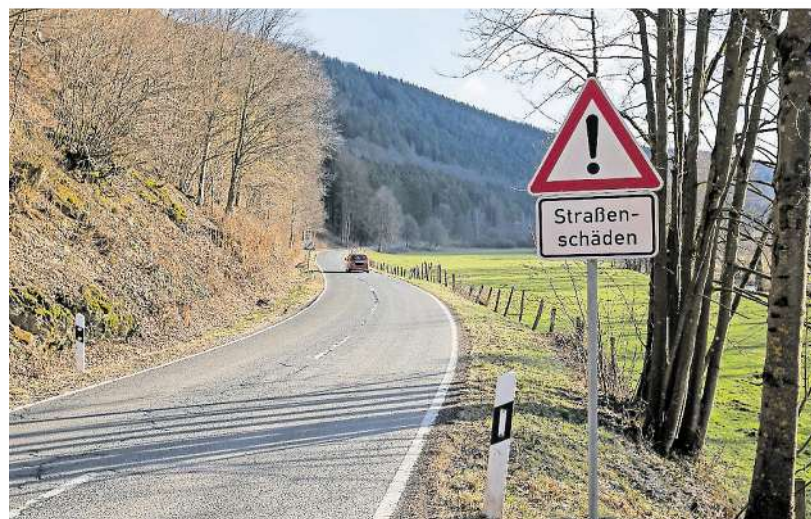
Am Eifelsteig ist die Aussicht auf den Ort, in dem Kurt Bongard (links) und Helmut Kaulard (rechts) aufgewachsen sind, besonders schön. Dort lädt seit Oktober ein neuer Rastplatz zum Verweilen ein. Bild unten links: Die L106 zwischen Dedenborn und Hammer befindet sich schon länger in einem schlechten Zustand. Schilder weisen auf die Straßenschäden hin. Bild unten rechts: Dass es auf dem Hans-Josef-Hilsenbeck-Platz auch eine Boulebahn gibt, soll im Rahmen eines Festes herausgestellt werden.
